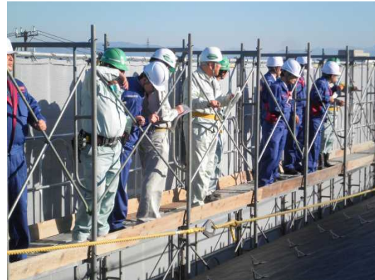
屋上での現場安全点検（新潟会場）
