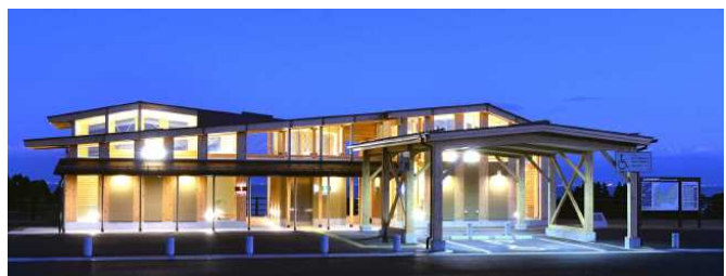
夜間におけるトイレ全景
