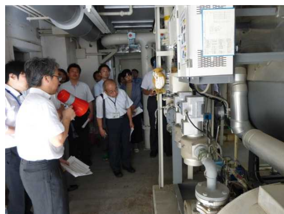
点検実地講習の状況（富山会場）
