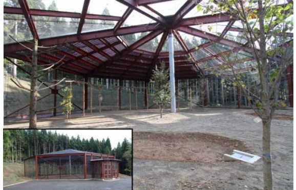
トキ保護センター(13)飼育ケージ新築工事
