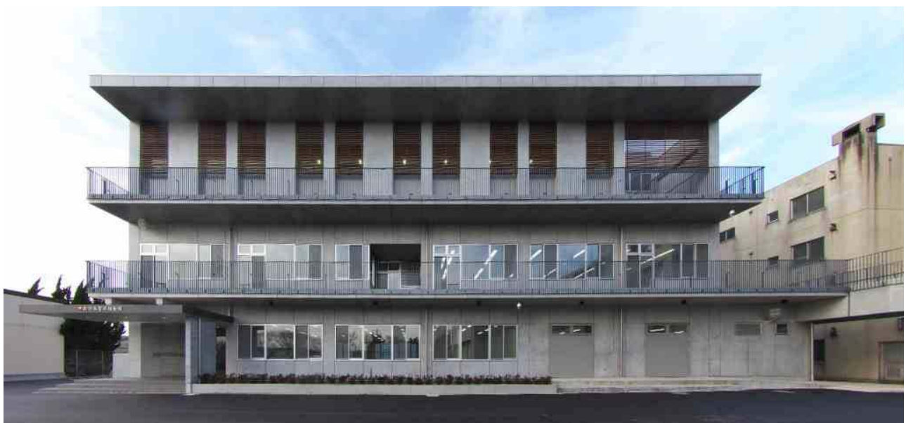
新潟県警察機動隊庁舎棟
