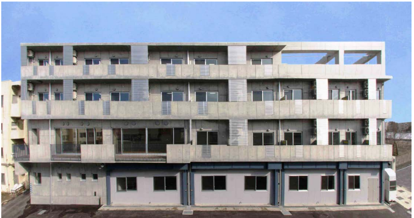
新潟県警察機動隊宿舎棟
