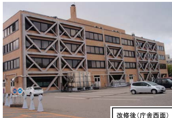
改修後(庁舎西面)
