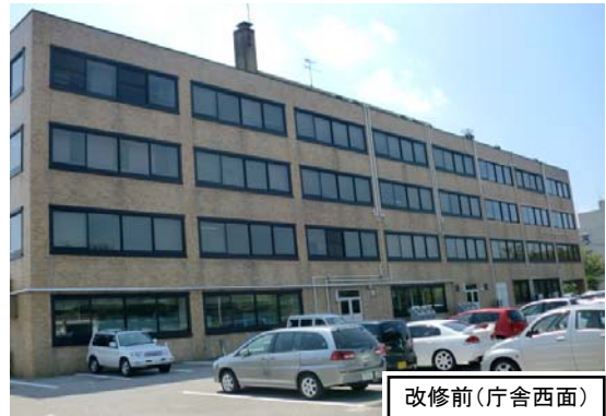
改修前(庁舎南面)正面玄関側
