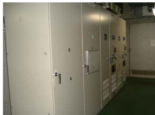
写真2 受変電設備
