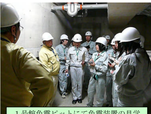
1号館免震ピットにて免震装置の見学
