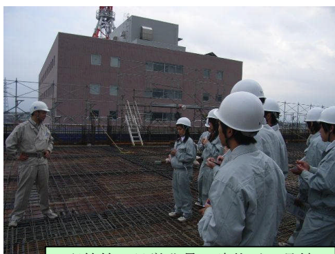
配筋等の見学背景の建物が1号館
