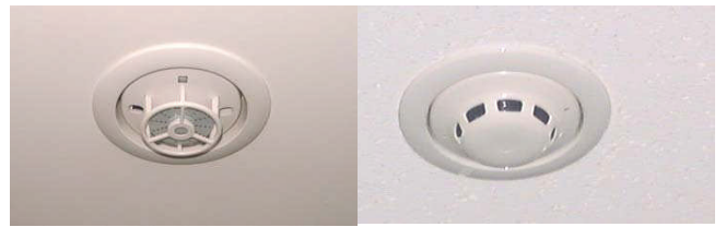
写真7 差動式感知器（左）と煙式感知器（右）
