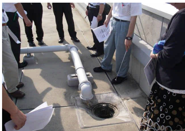
法定点検実地講習状況(新潟地区)
