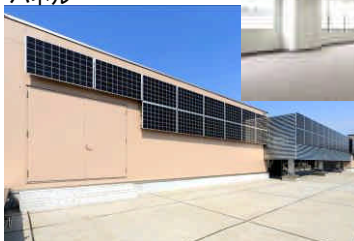
壁面設置太陽光パネル
