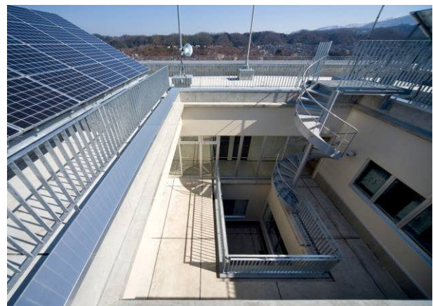
屋上の太陽光発電パネルと中庭
