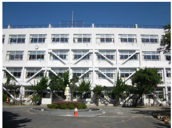
大形小学校校舎 外観
