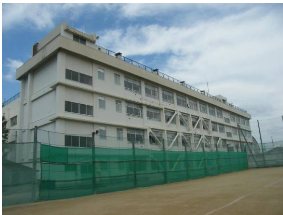
牡丹山小学校校舎 外観
