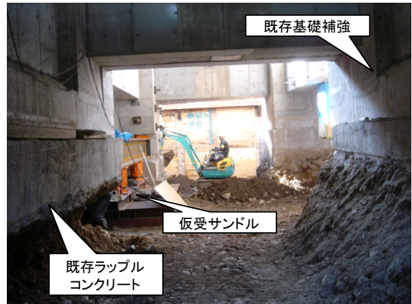
基礎底レベルより下を掘削：工程⑥
