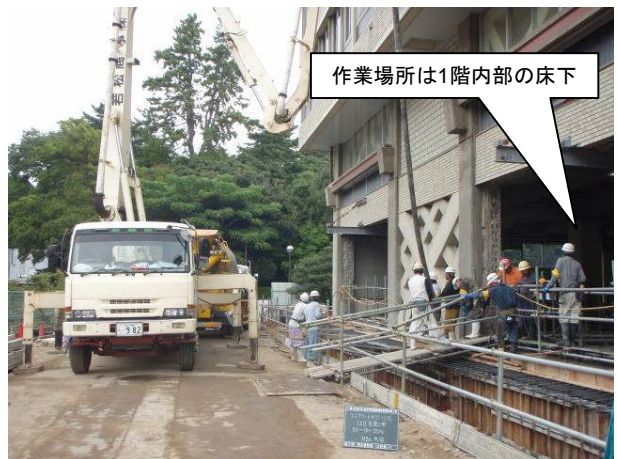
既存基礎・基礎梁の補強コンクリートを打設:工程④
