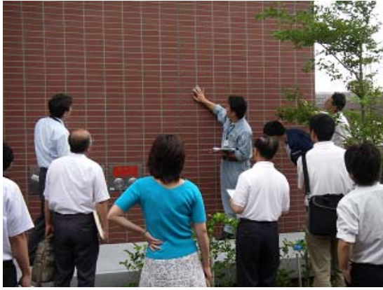
屋外での外壁タイル点検状況
