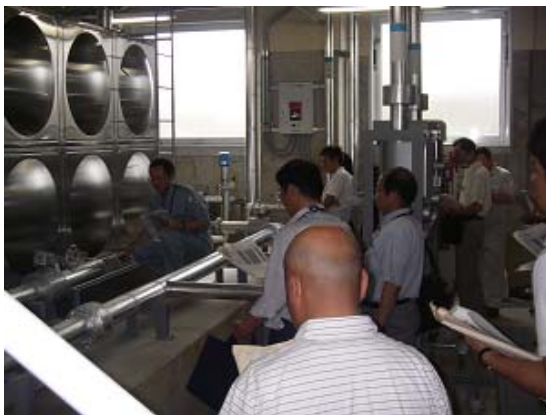
機械室での受水タンク点検状況
