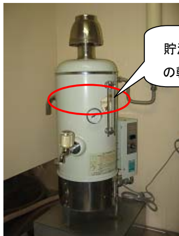
事例7：転倒防止措置不良
