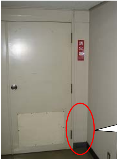
事例 2 : 消火設備の操作・ 使用に支障 (1)
