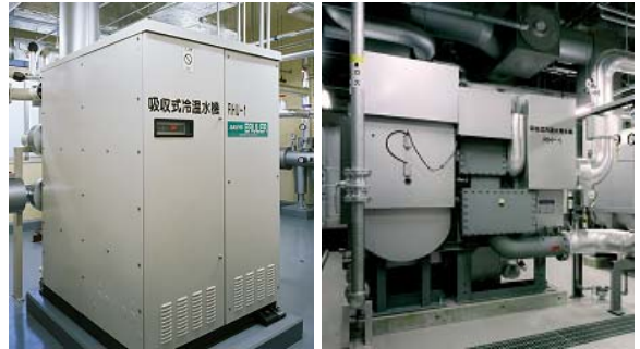
冷温水発生機:小形ユニット(左) 大形(右)
