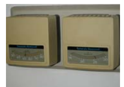
自動制御機器: 温湿度調節器
