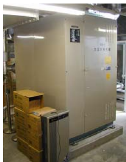
熱源機器: 周囲に可燃物が 置かれている
