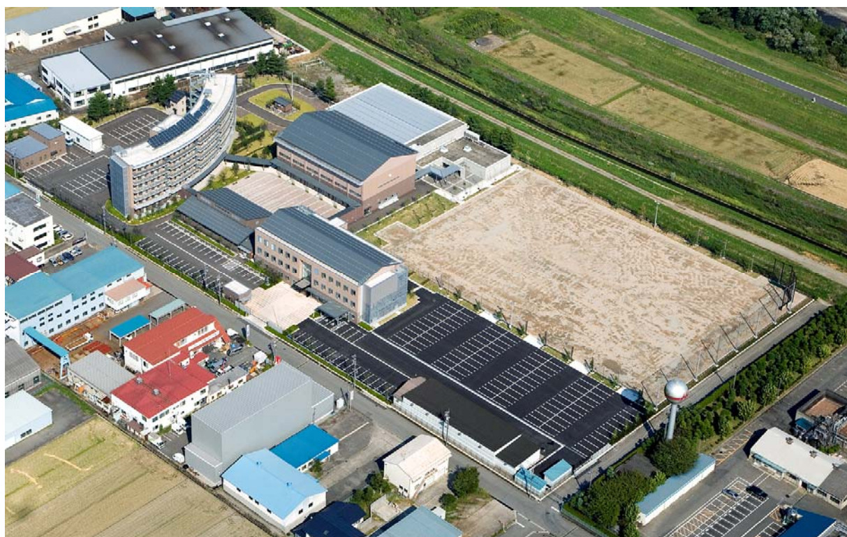
全 景 (左奥から学生寮、厚生棟、本館、中庭対面に体育館・武道場、その奥は既存射撃場)
