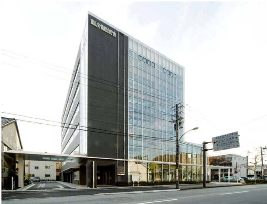
富山県労働総合庁舎 外観
