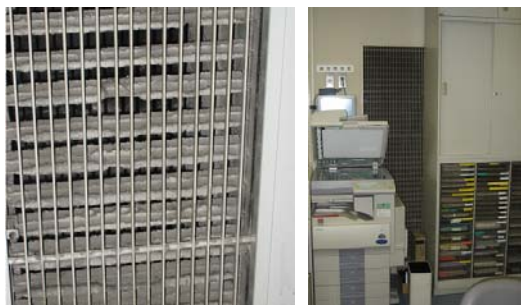
レターンガラリ: 埃が付着している(左) 前面がロッカーで塞がれている(右)
