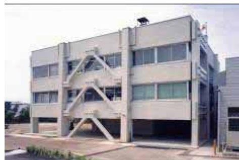
耐震改修実施例(小千谷税務署)
