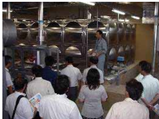
定期点検の実地説明状況(受水タンク)
