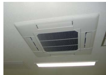
室内機:カセット形4方向吹出しの例
