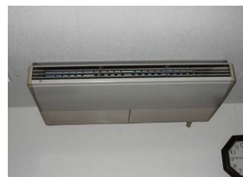
室内機:天井吊り露出形の例
