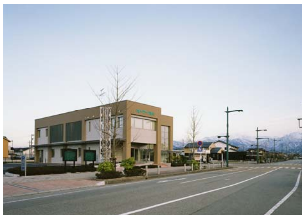
庁舎外観(南西側)
