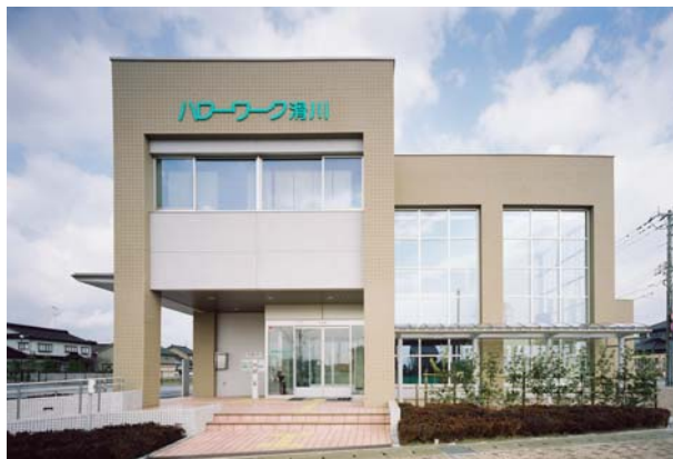
庁舎外観(南側)
