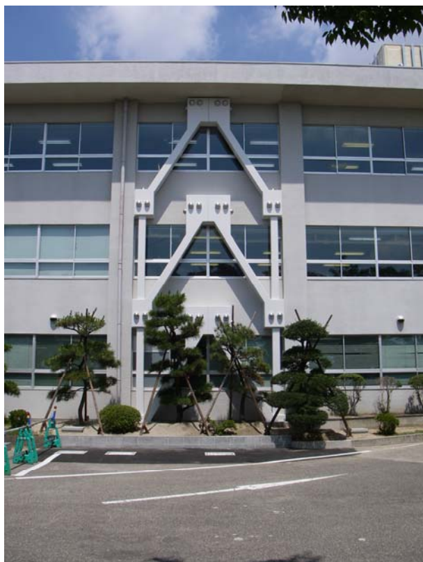
ブレース部分拡大
