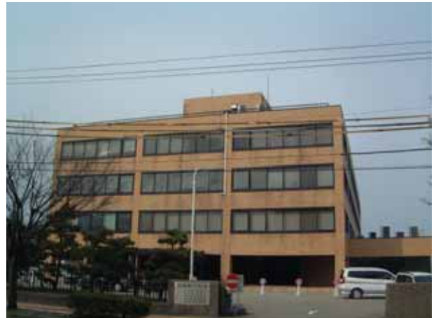
新潟法務総合庁舎 (アスベスト対策工事を予定)
