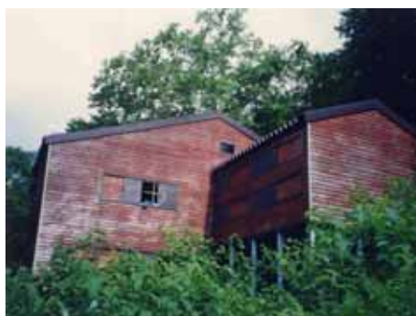
冬山前進基地 (S44竣工)
