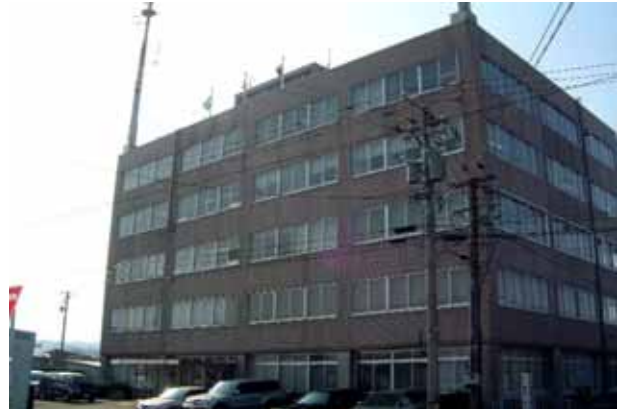
伏木港湾合同庁舎 (耐震改修工事及びアスベスト対策工事を予定)
