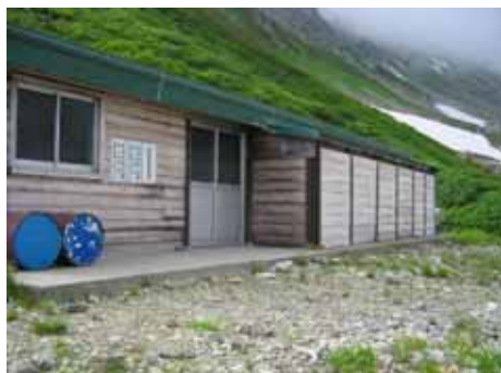
夏山前進基地 (S43竣工)
