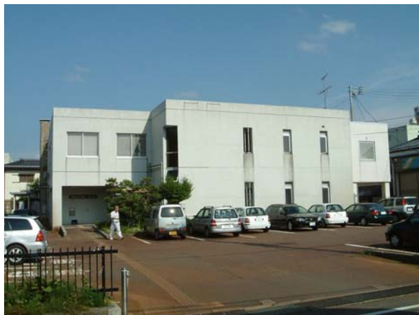
改修前 庁舎全景
