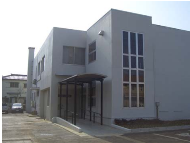
改修後 庁舎エレベーター増築部分
