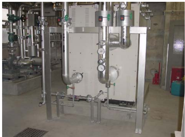
改修後の機械室内部
