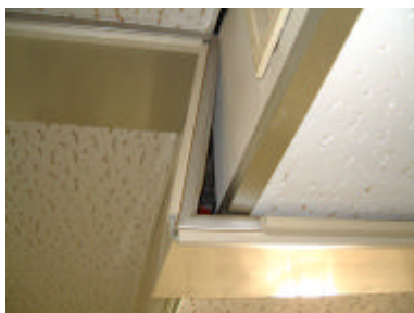
写真4 EXP-Jカバーのずれ
