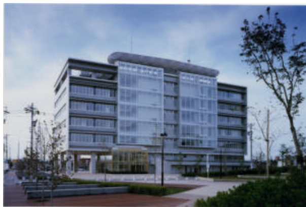
小松日の出合同庁舎 北東面外観
