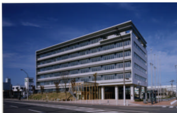
小松日の出合同庁舎 南東面外観
