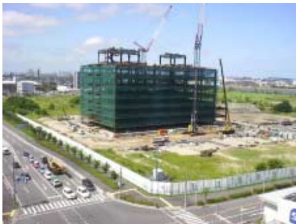
新潟第2合同庁舎A棟 工事中写真（6月末）
