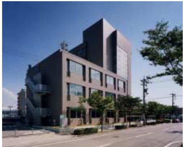
金沢駅西合同庁舎増築棟 北東面 外観
