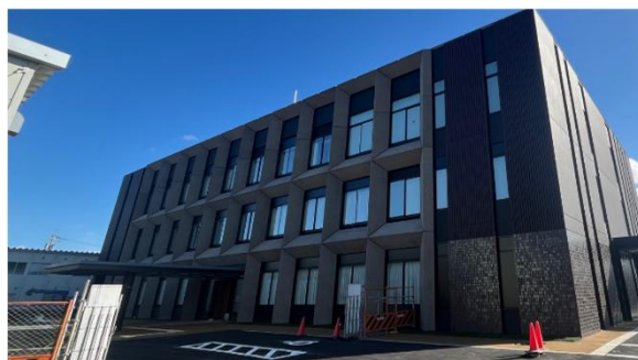
富山地家裁高岡支部庁舎 外観（外構は工事中）
