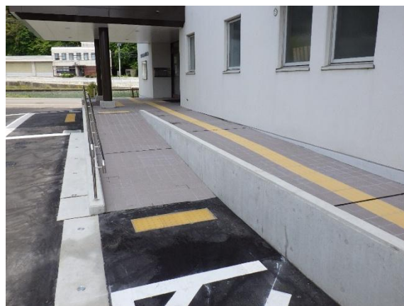
穴水地方合同庁舎 外構復旧後
