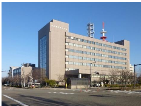
金沢駅西合同庁舎
