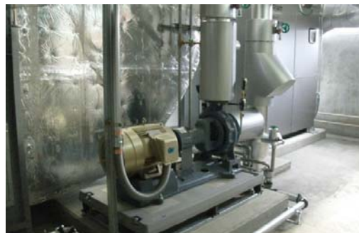
新潟港湾合同(12)空調設備改修工事
