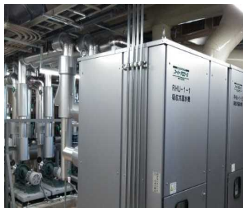
改修後の機械室
