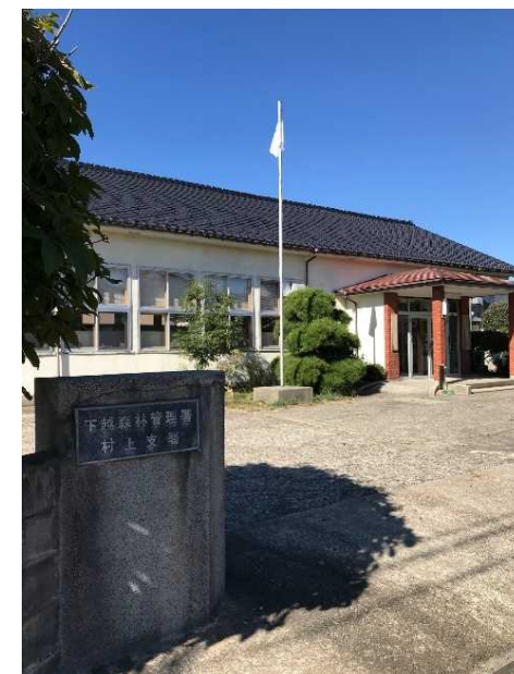
庁舎外観（現状）
