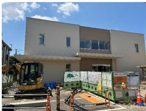
【新潟地方検察庁三条支部外観(外構工事中)】
