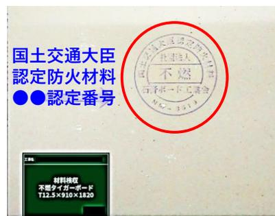
品質・規格等が確認できる材料搬入時の工事写真
