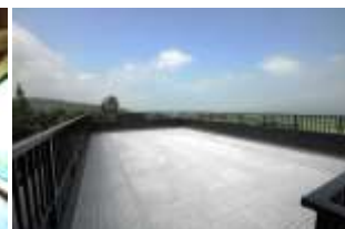
屋上観察スペース
