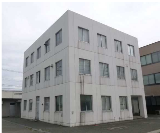
北陸農政局新潟支局庁舎 (既設)
