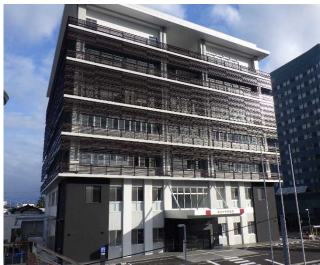
(仮称)富山中央警察署竣工時外観
