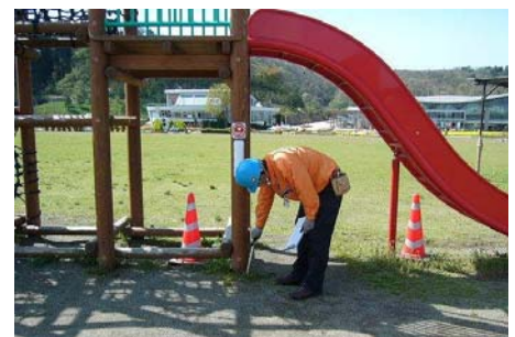
木製遊具点検
