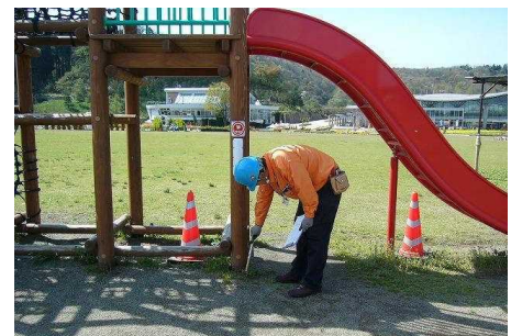
木製遊具点検
