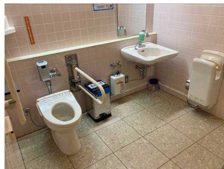
ニーズの多様化に対応するトイレ改修
