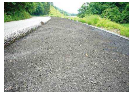
間伐材のチップを使用した舗装
