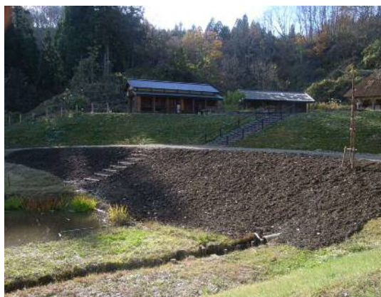
ウッドチップマルチング(竣工)
