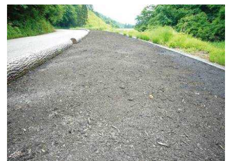
間伐材のチップを使用した舗装
