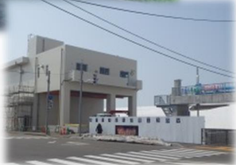
柿川放水路 排水機場
