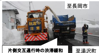
片側交互通行時の渋滞緩和 現道区間における運搬排雪作業状況 (令和4年1月)
