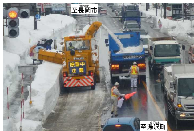
令和3年現道区間における運搬排雪作業状況(片側交互通行規制)
