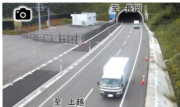
開通区間(撮影日: 令和5年10月17日)
