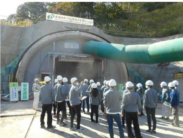
【柏崎バイパス】山岳部トンネル
