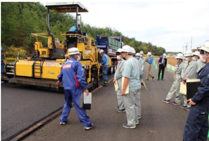
【舗装工事の説明】
