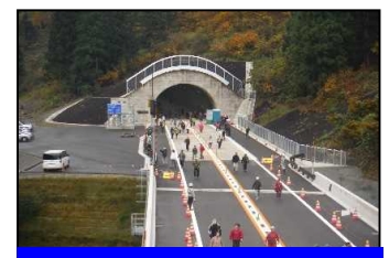
南魚沼側トンネル坑口付近
