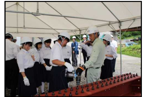
高力ボルトの締め付け作業を体験
