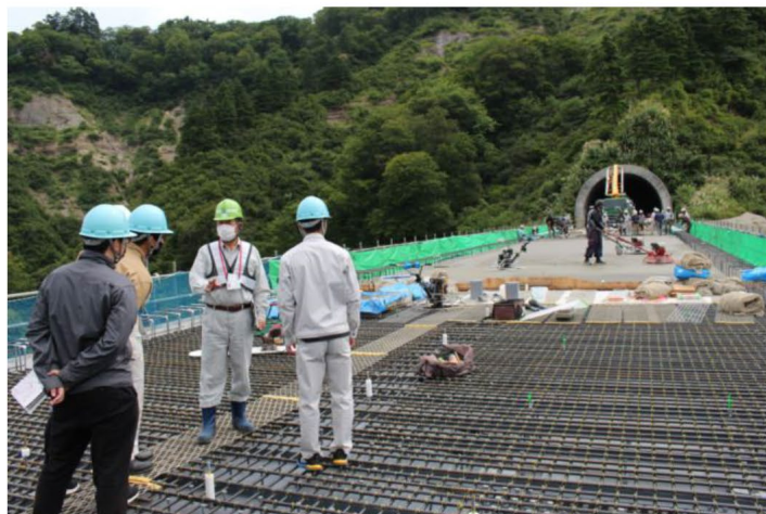
【5号橋梁床版工事の説明】
