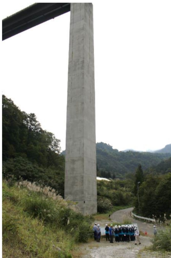
【5号橋梁の工事説明】
