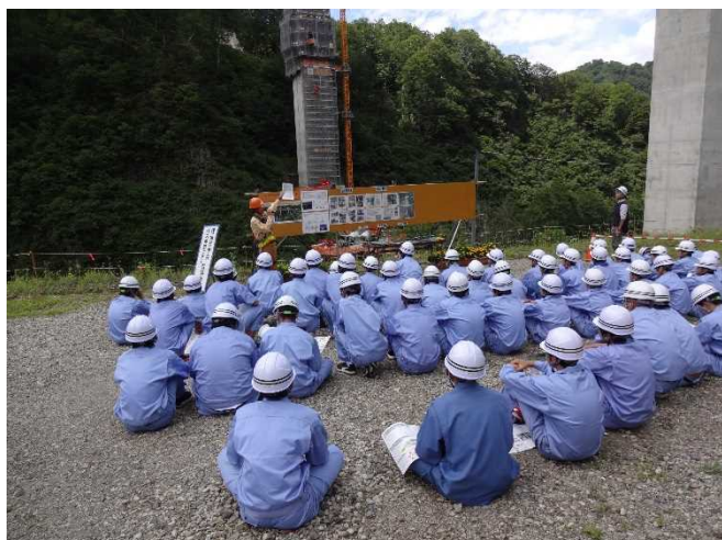
5号橋梁 橋脚橋梁工事の説明
