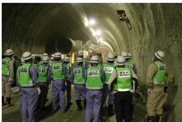
1号トンネル 内部にて工法・建設機械等の説明
