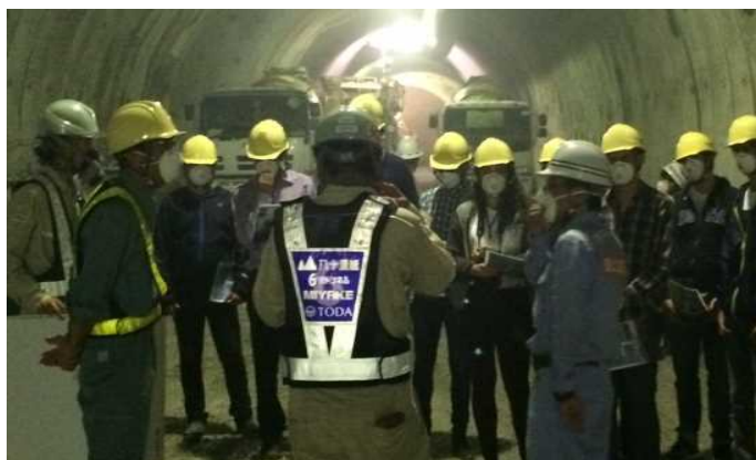
トンネル掘削先端部で熱心に説明を聞いていました
